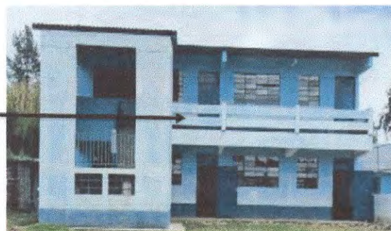
Foto 10: Repello en muro
