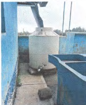
Foto 7: Sustrucción de depósito de agua 1700 litros.
