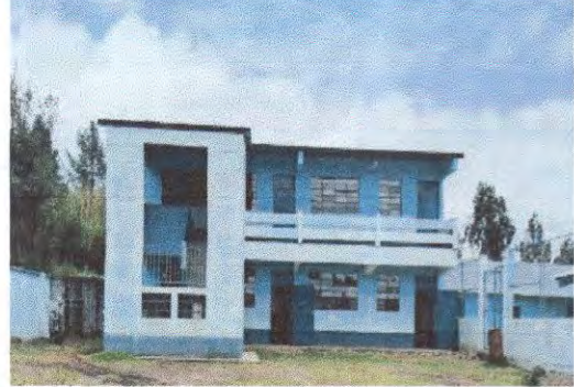
Foto 2: Pintura en muros exteriores e interiores
