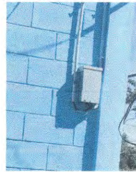
Foto 4: Sustrucción de flipones
