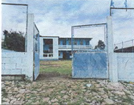
Foto 1: Sustrucción de portón de metal
