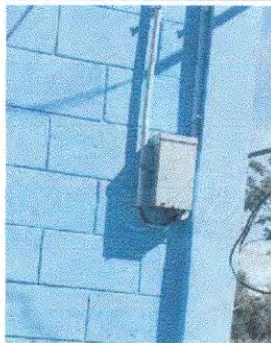
Foto 5: Sustrucción de tablero de flipon
