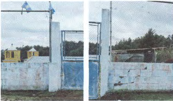
Foto 3: Reparación en muro perimetral de blok
